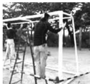
サッカーゴール補修
