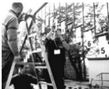
タッチパネル補修
