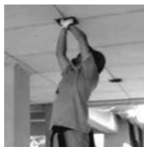
ピロティ電球補修
